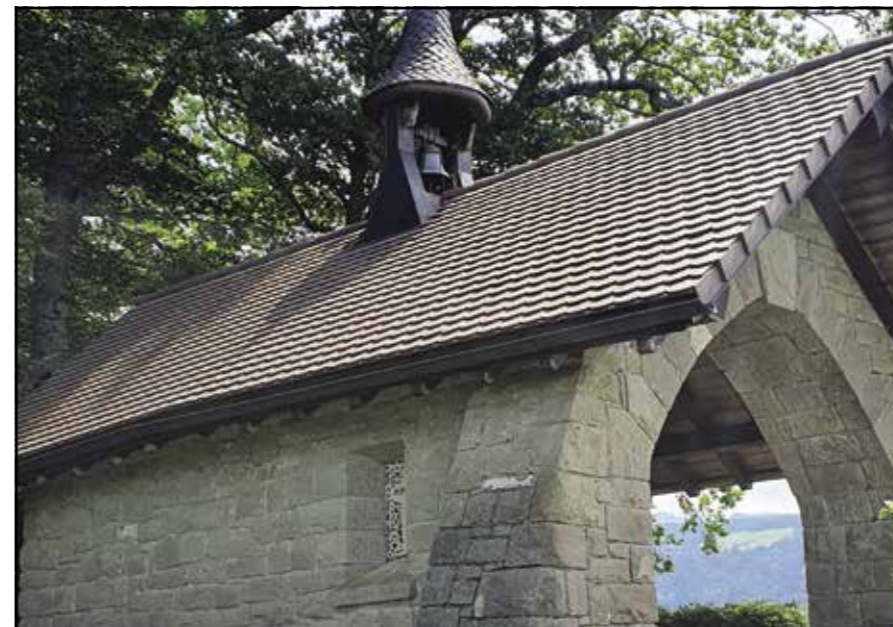
Chapelle du Jordil, vue extérieure
